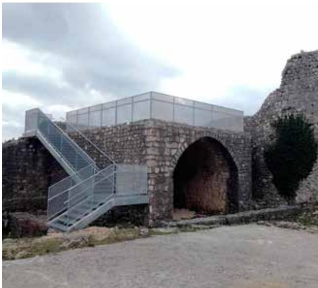
10 Projekt uređenja vidikovca sa stubama na gornjem nivou tvrđave Topane – pogled na istok i pogled na sjever (foto: M. Zelić, fototeka KIM, 2017.)
