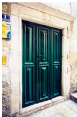
10 Projekt 10: stanje nakon intervencije Project 10: condition after restoration
