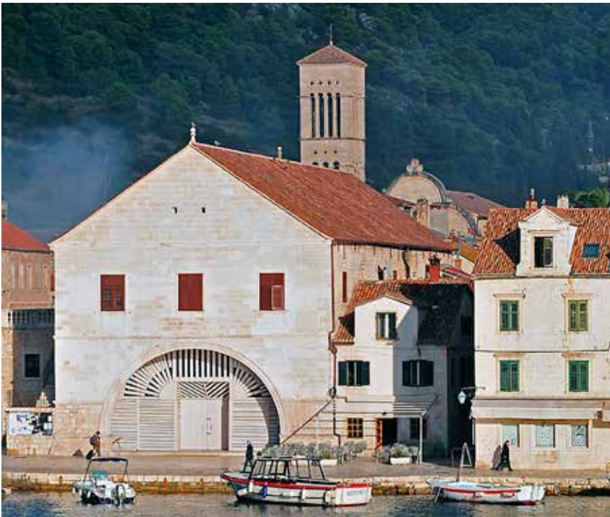
2 Projekt obnove Arsenala i kazališta u Hvaru – Godišnja „Nagrada Vicko Andrić“ za 2018. godinu. Pogled na obnovljeno zapadno pročelje.
