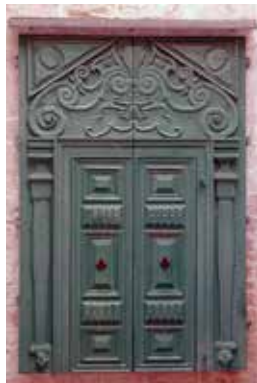
2 Projekt 1: stanje 2010. godine u tijeku prezentacije Project 1: condition in 2010, during presentation
